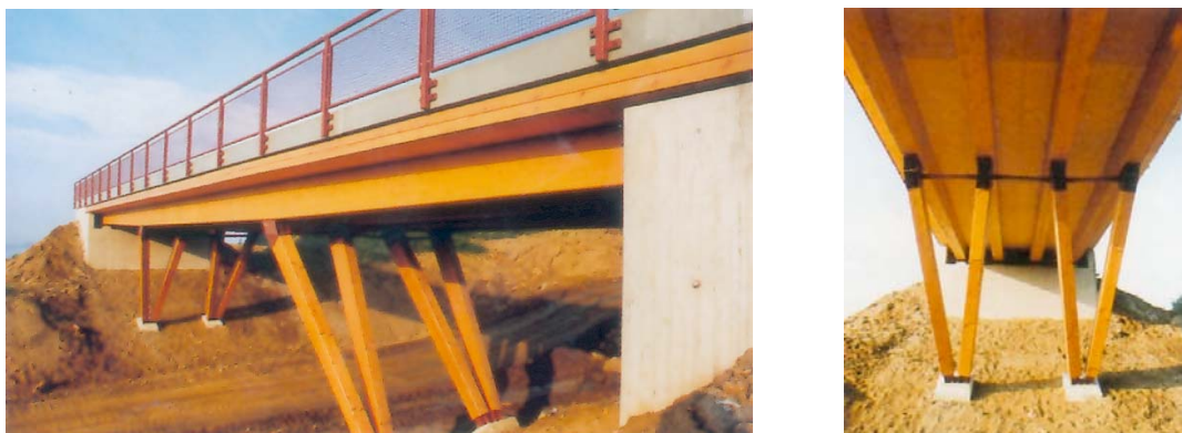
Bild 3.2-1: Straßenbrücke Ruderting; links: Ansicht, rechts: Untersicht. Quelle:[67]
